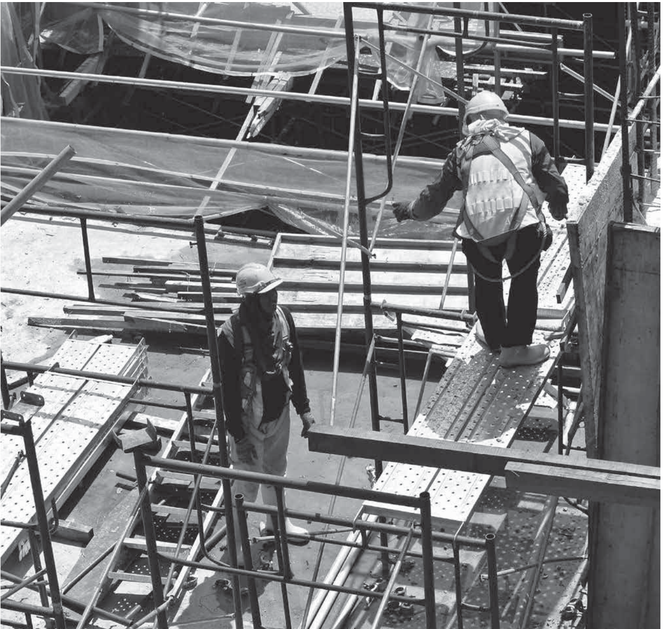
Construction work SA
